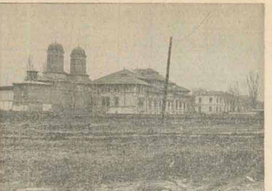
Biserica Antim. În colțul din față stînga Cuhnia ulterioară demolată (primăvara — vara 1994)
