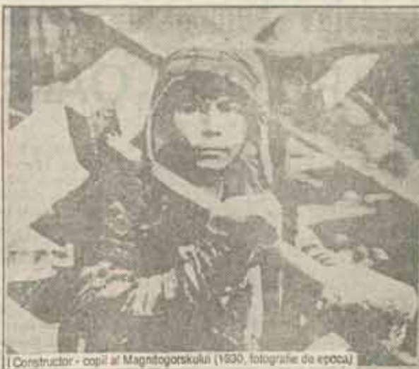
Construcător - copil al Magnitogorskului (1930, fotografie de epocă)
